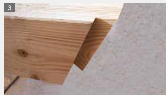
1 Particolare costruttivo con posa uniforme dello strato isolante di fibra di legno 2/3 Innesto travatura m/f a coda di rondine
