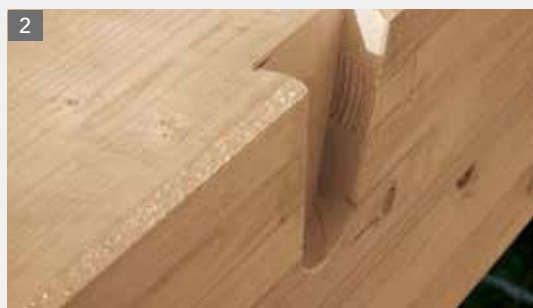
1 Particolare costruttivo con posa uniforme dello strato isolante di fibra di legno 2/3 Innesto travatura m/f a coda di rondine
